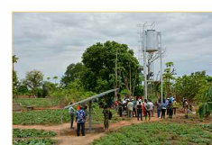
50,66 ha de périmètres maraichers aménagés
