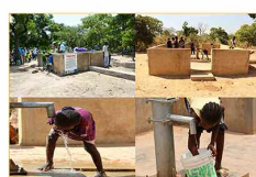
75 forages implantés au profit des communautés
